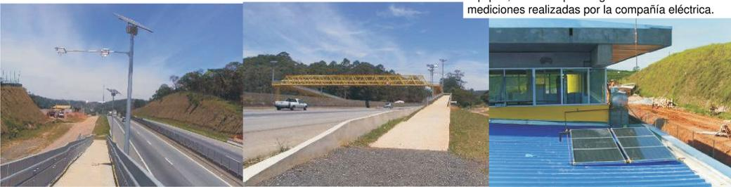
Figura 1 - Iluminación de las pasarelas en los Km 57+100, 55+950 en Mairiporã/SP y Km 49+100 en Atibaia/SP y realizada por medio de la captación de energía solar por paneles fotovoltaicos.
